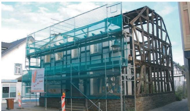
Abb.42: Rückbau des alten Fachwerkhauses bis auf das Ständerwerk
