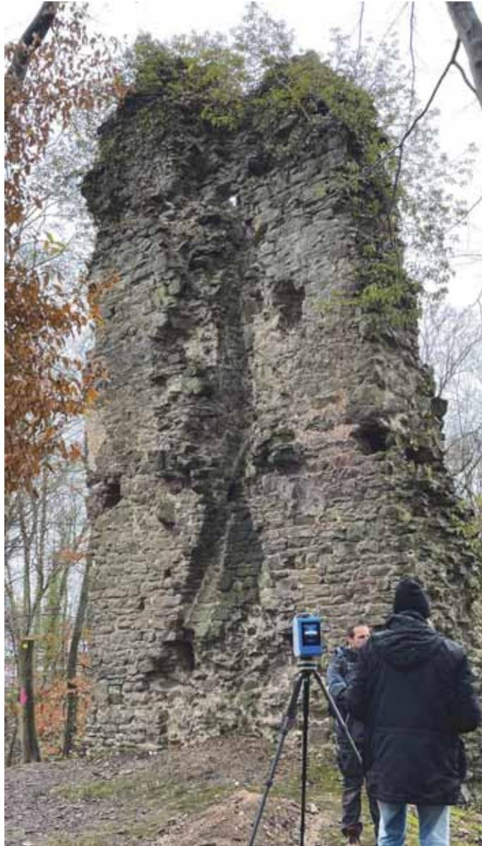
Die vom Efeu befreite Mauer mit Spuren des Kamins eines repräsentativen Festsaaes wird von der TH Köln mit dem Laserscanner vermessen. (J. Berthold, LVR-ABR)
